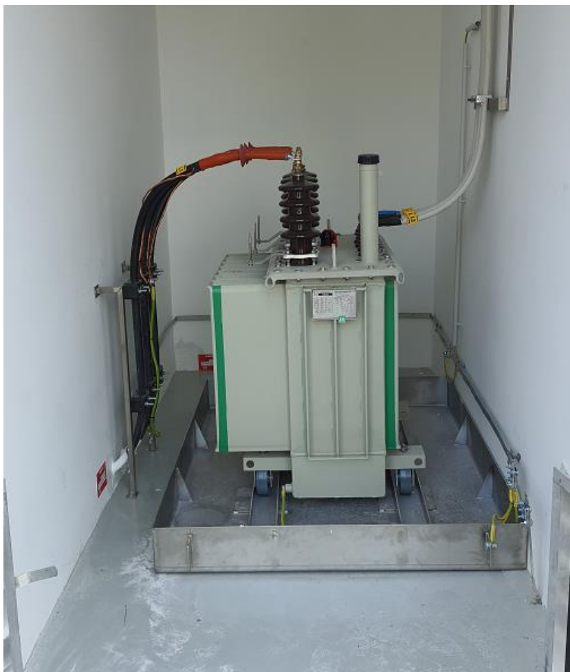
Slika 4-4: Primer vgradnje in montaže TR
